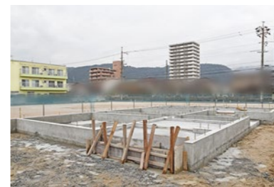
【基礎コンクリート養生中】
